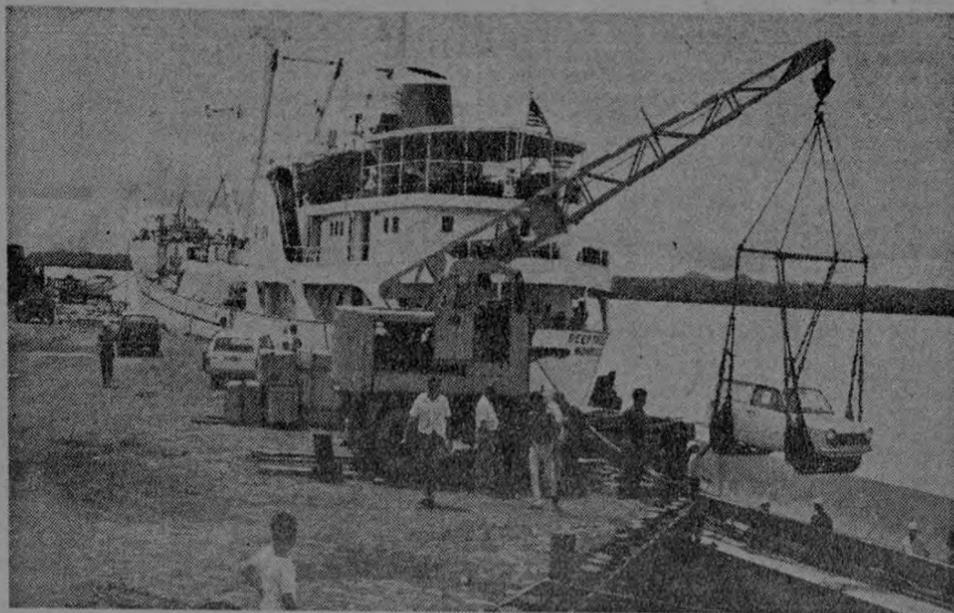
Aspcto que presenta el muelle de Cocal recién construido, y que ya está en pleno funcionamiento para barcos de regular calado. Cuando entre en operación la nueva draga que acaba de ser adjudicada, podrá recibir este muelle barcos hasta de cinco mil toneladas.
