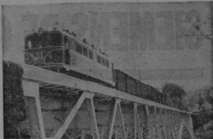
El puente sobre el río Grande. Es el de mayor longitud en el recorrido de San José a Puntarenas.
