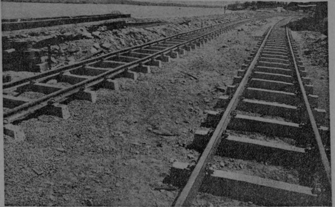
El Ferrocarril ha implantado el sistema de traviesas de concreto pretensado, y rieles soldados. Esto significa un ahorro
